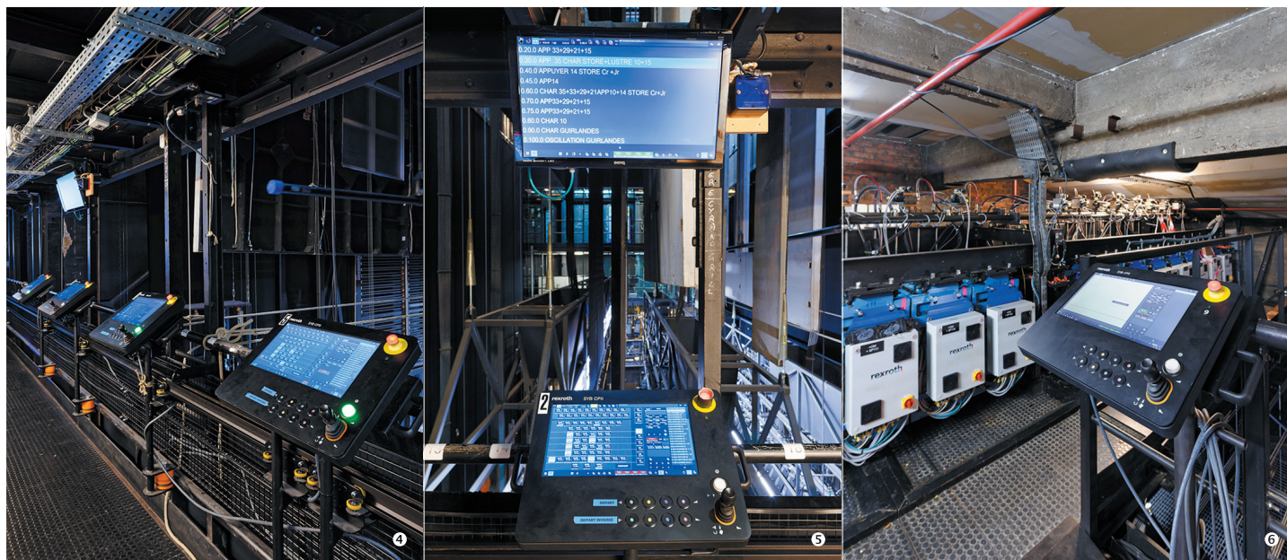
④ Pupitres Bosch Rexroth, passerelle 1 er service (CF) ⑤ Poste de travail du cintrier, écran de contrôle des manœuvres (CF) ⑥ Pupitre Bosch Rexroth au gril, recalibrage des ponctuels (TCE)
