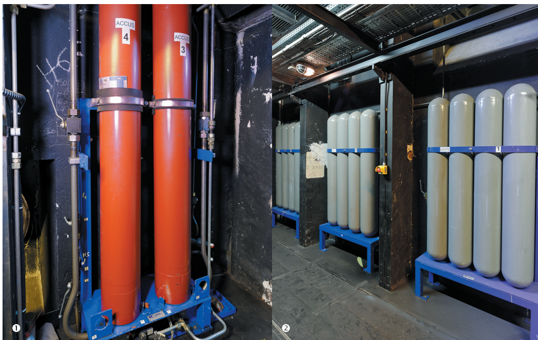
① Accumulateurs à piston huile/azote (CF) ② Réserves d'azote en bouteilles sous pression
